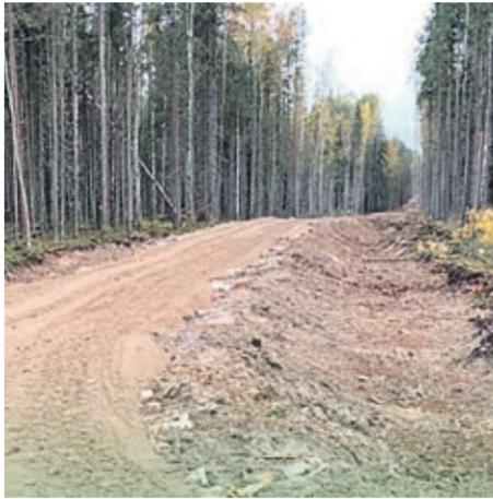
Устьянский участок Устьянского ЛПХ завершил строительство новой дороги к лесфонду Студенецкого участкового лесничества. Дорожная служба выполнила пробалку и отсыпку всего участка маршрута протяженностью шесть километров. Дополнительно для обеспечения бесперебойной вывозки в период распутицы подразделение приводит в порядок 15-километровую дорогу общего пользования от поселка Студенец — производится ямочный ремонт, оканавливание и подсыпка проблемных мест, грейдирование.
